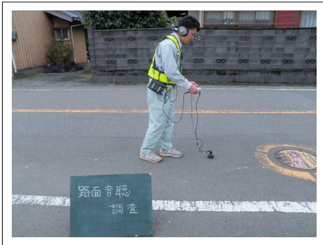
道路内に埋設されている水道管上を専用機器を携えて歩き、水の流出音を聴くことにより、漏水有無を調べる調査です。
