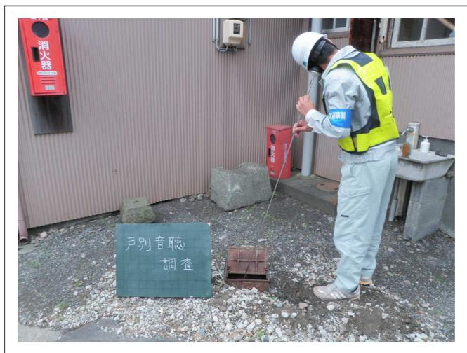
各ご家庭に設置されている水道メーターから水の音を聴くことで、漏水の有無を調査します。
